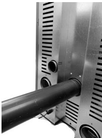
Fig. 47 - Anschluss des Rauchgasauslasses
