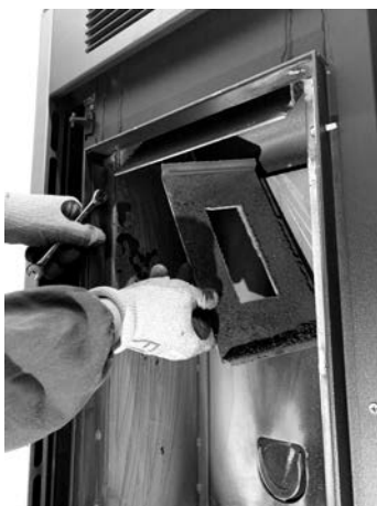
Fig. 99 - Die Stirnseite des Feuerraums 2 entfernen
