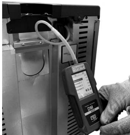
Fig. 89 - Anschluss des Digitaldruckwächters (Atena³ Plus12/14 - Duke 12/14 At - Saba 12/14)
