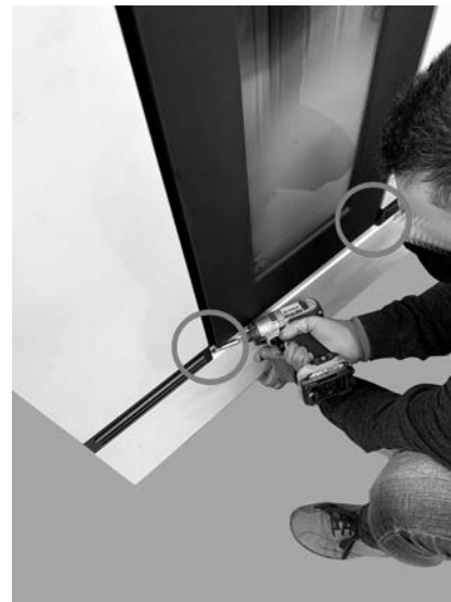
Fig. 44 - Die untere Platte befestigen
