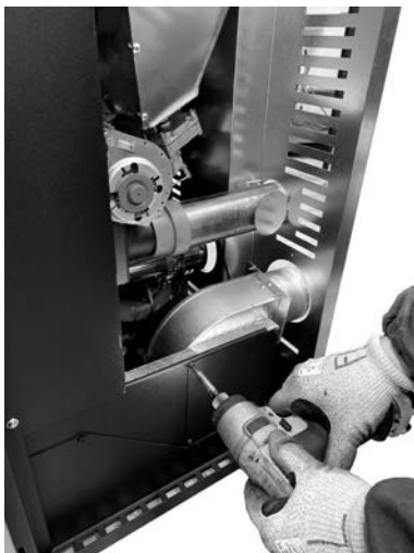
Fig. 61 - Stopfen entfernen
