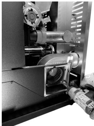
Fig. 62 - Die Ventilatorschrauben entfernen
