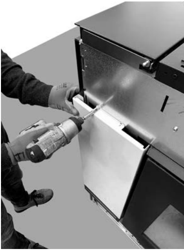
Fig. 36 - Befestigung der Seitenwände
