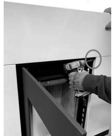
Fig. 41 - Die obere Platte befestigen
