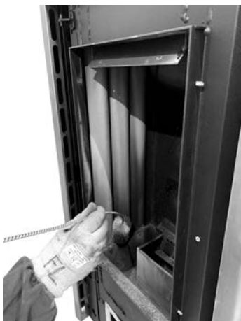
Fig. 102 - Mit einer Rohrreinigungsbürste reinigen
