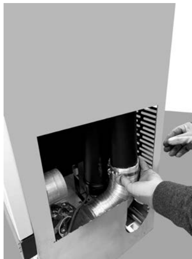
Fig. 83 - Die Rohre anschließen
