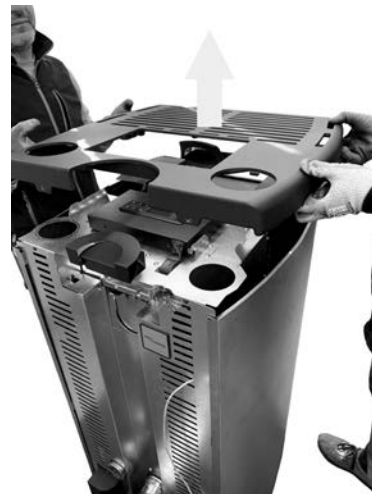
Fig. 21 - Die Abdeckung entfernen
