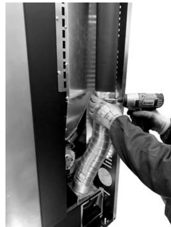
Fig. 66 - Die Rohre befestigen
